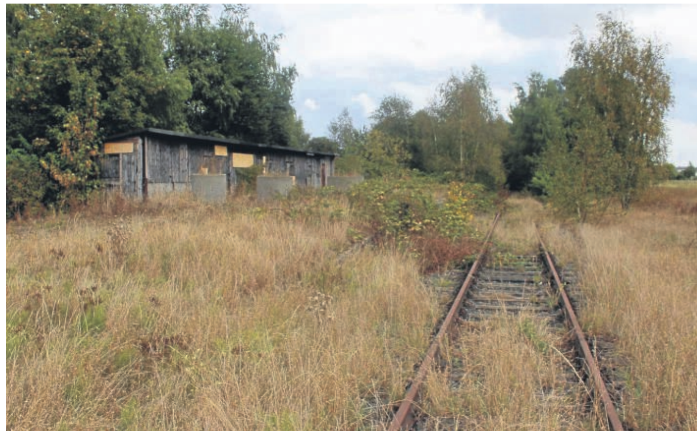
Vor 95 Jahren bekam Siedenburg den Bahnanschluss, damals ein wichtiger Hoffnungsträger. Doch das ist heute längst Geschichte. Der letzte Zug ist hier längst abgefahren. Spuren aus der Eisenbahnzeit gibt es aber noch immer. Fotos:Dümer
