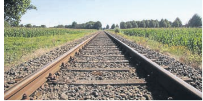
Die Bahnstrecke Richtung Barenburg.
